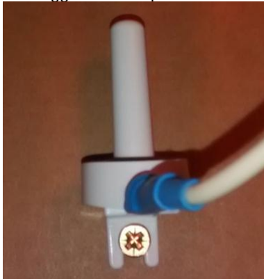
Montaggio sensore pannello solare
